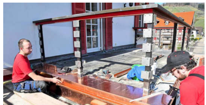
Blech- und Installationsarbeiten wie hier bei einer Kappelroederer Firma ist eine der Kompetenzen der Firma Sontheimer. Zu sehen sind Jan Ketterer und Roman Schmälzle (von links).
